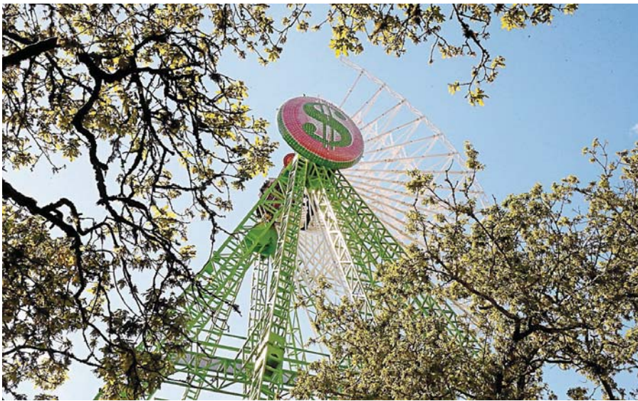
ALAMEDA Trabajos de montaje de la noria de las Festas da Ascensión, situada en el parque de la Alameda. Foto: F. Blanco
